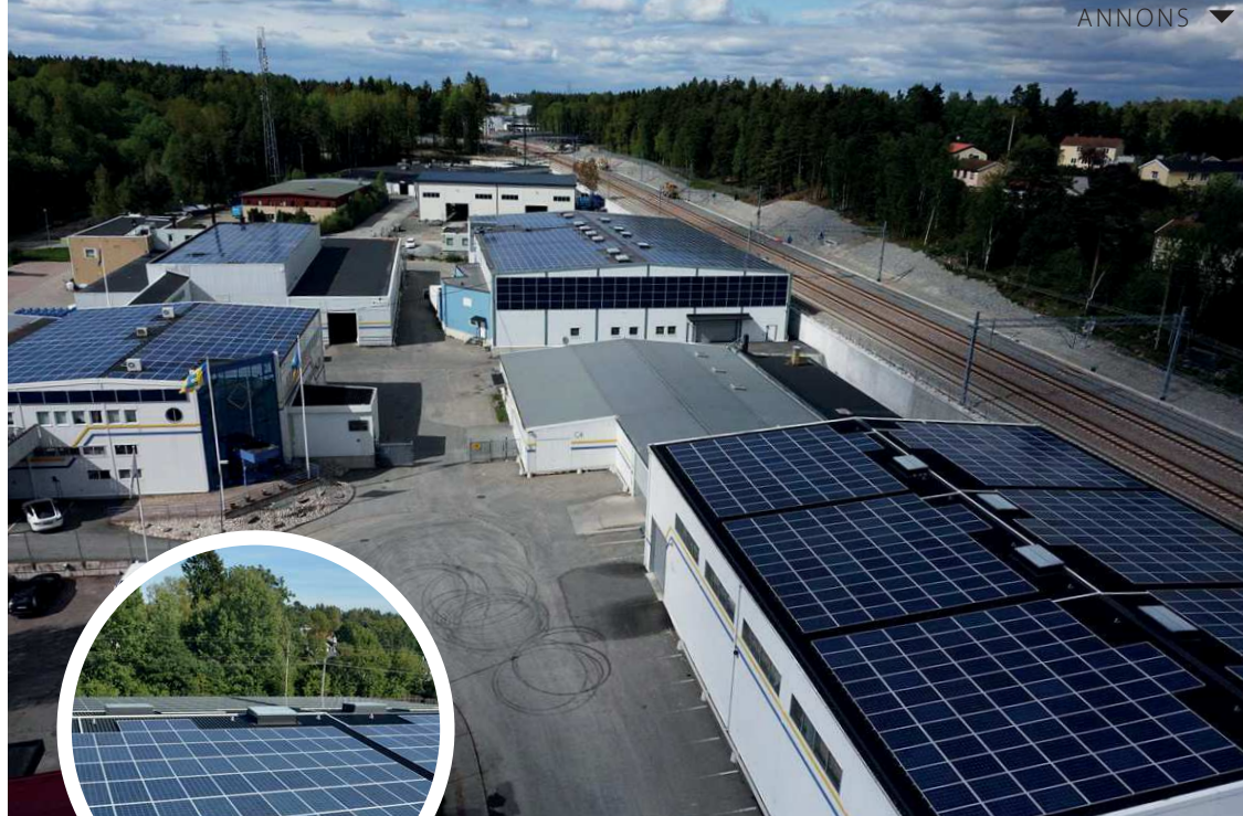
Produktionsanläggningen i Stockholm är självförsörjande på energi. På taket och väggarna finns totalt 2 500 solpaneler.
